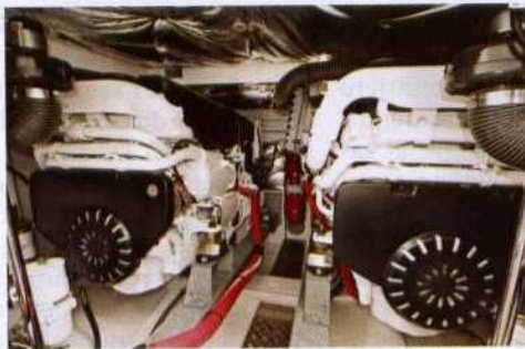
La sala macchine ospita i due grandi motori Volvo Penta da 575 cavalli.
